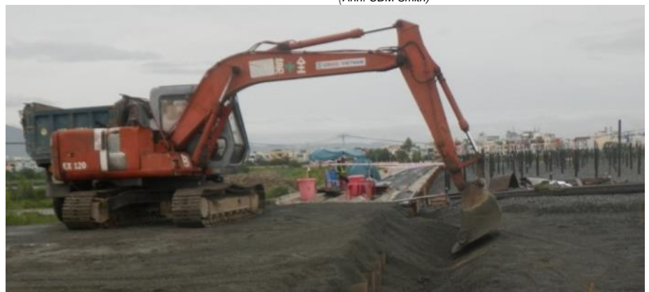
Phủ lớp đá dăm lên bề mặt đỉnh của kết cấu móng (Ảnh: CDM Smith)
