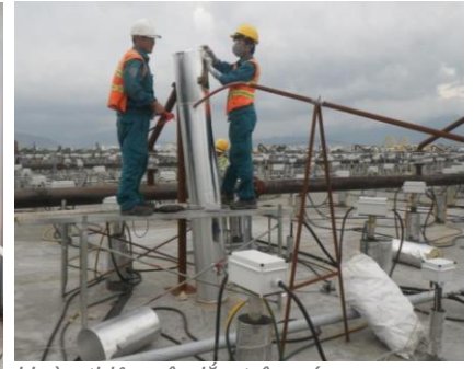
Hoàn thiện xây lắp trên nóc kết cấu xử lý (Ảnh: CDM Smith)
