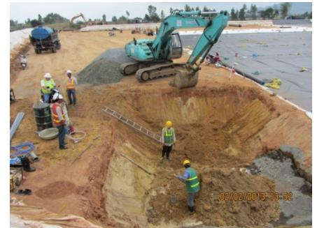
Thi công hồ gom trong sân phơi để thu gom nước (Ảnh: CDM Smith)
