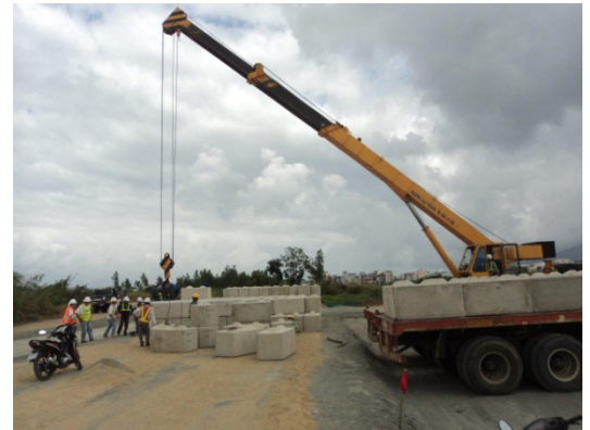
Lắp đặt tường của kết cấu mố bằng khối bê tông CMU (Ảnh: CDM Smith)
